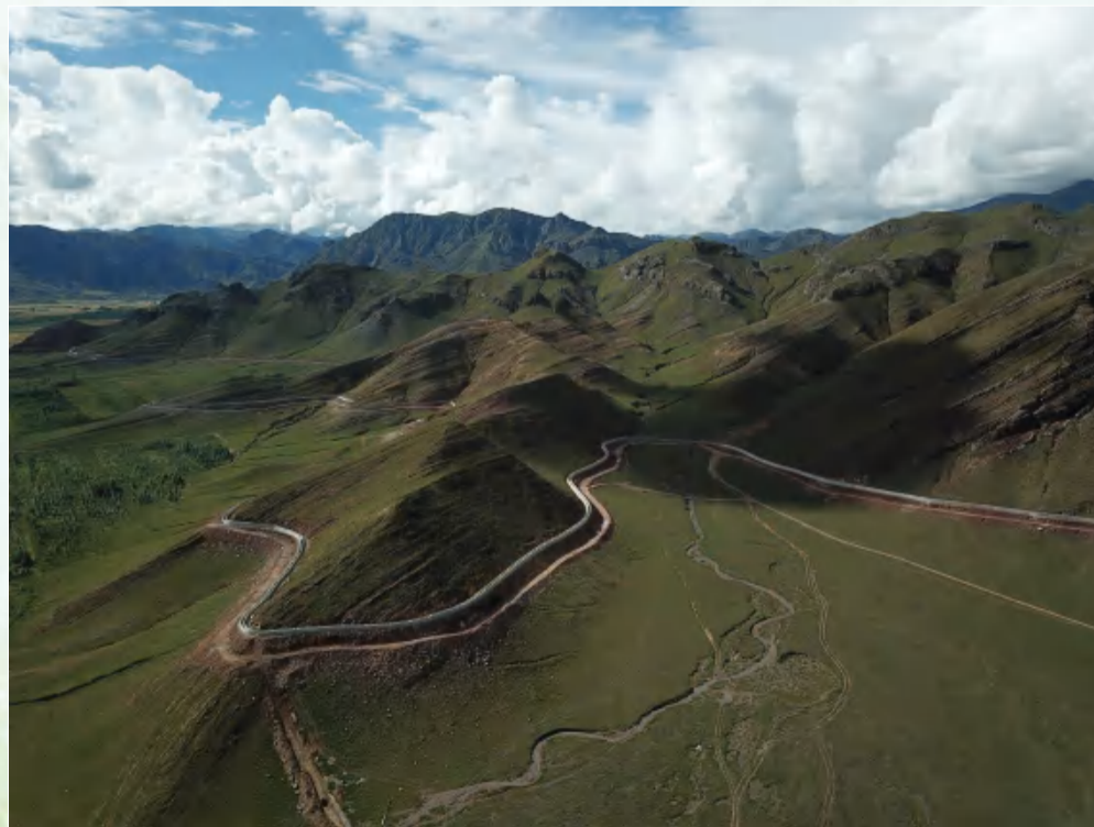
由水利水电集团承建的拉萨市澎波灌区白浪区等子灌区工程,位于拉萨市林周县城境内,目前该项目已基本完工。项目建成后,可有效灌溉现有耕地和可开发耕地,改善农牧业生产生活条件,提高群众生活水平,同时进一步改善该地区生态环境,实现水资源优化配置,促进地区经济的可持续发展。
