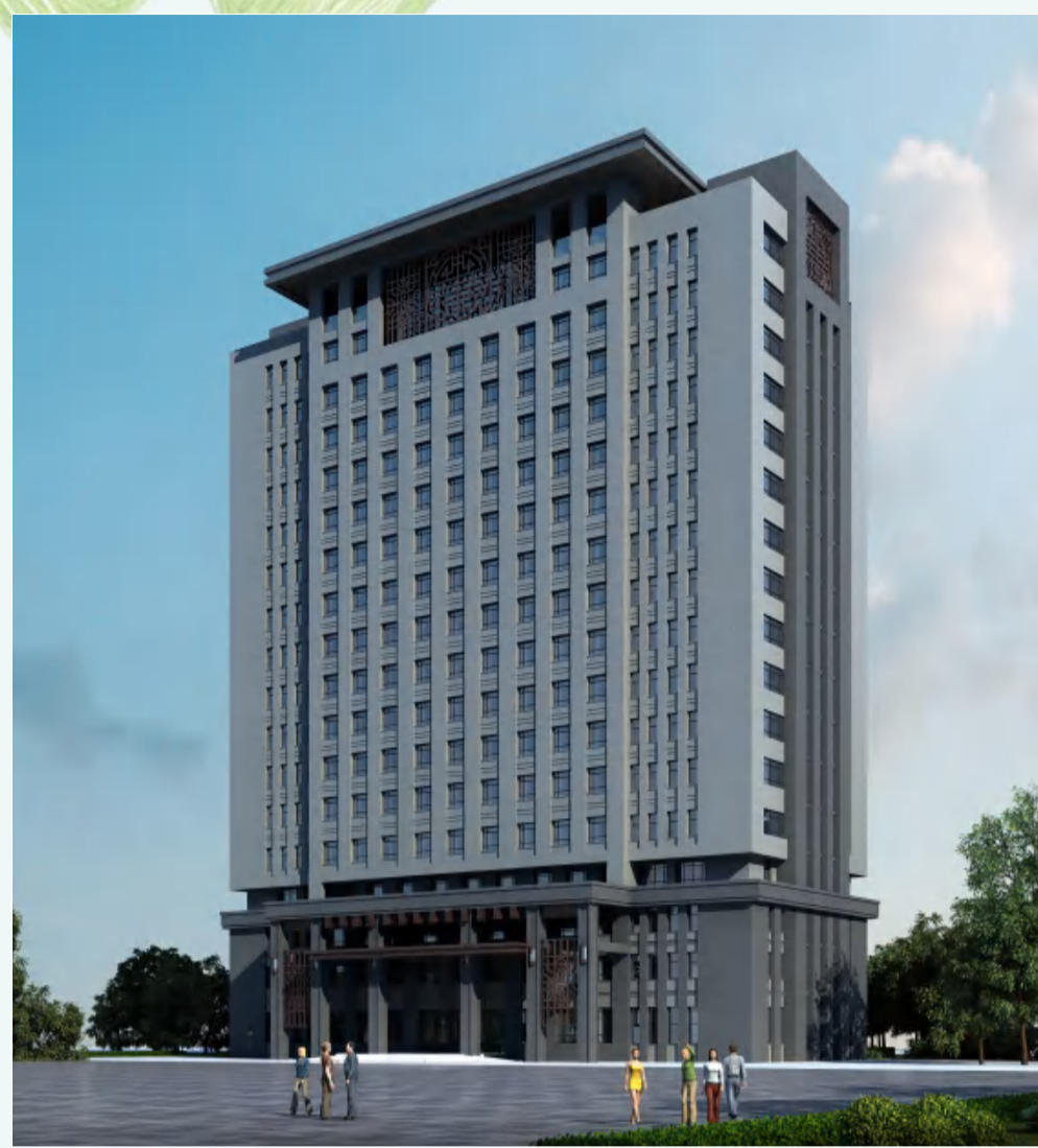
由建工集团承建的黑龙江中医药大学附属第一医院国家中药传承创新工程建设项目,主体已经完工,进入室内装饰阶段。项目总用地面积 23700 平方米,其中地上建筑面积 22212 平方米,地下建筑面积 1488 平方米;地下 1 层,地上 17 层。项目将建设成为以建设国家中医临床研究基地、国家中药传承创新工程为基础,以创建教学研究型学院为目标,中医药特色优势突出的综合性中医医院。
